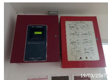
Fire Alarm Control Panel และ Graphic Annunciator Fire Alarm System
